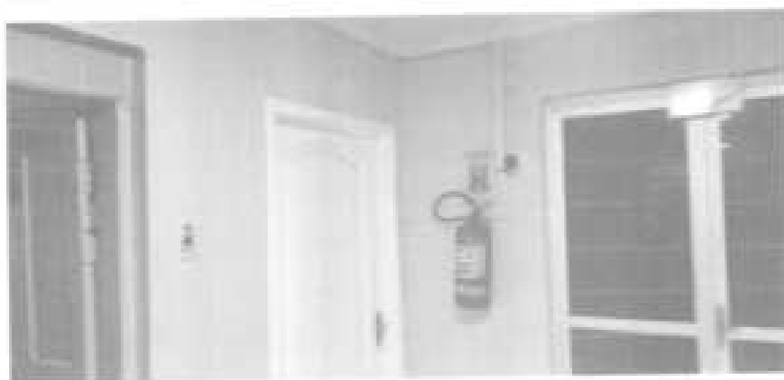
14.4 Acesso restrito ao público com corrimão de emergência. Não
